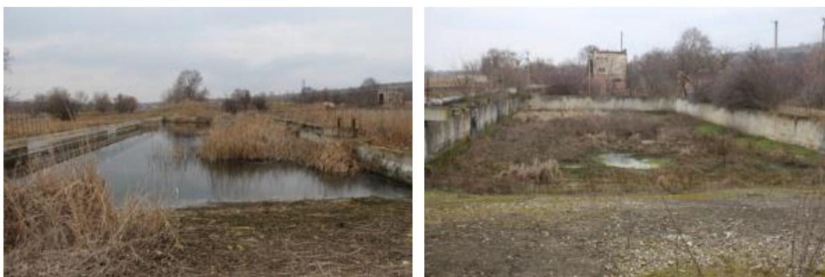
Figură 4-3 : Platforme in stare de incarcare cu nămol si in stare de deshidratare a nămolului
