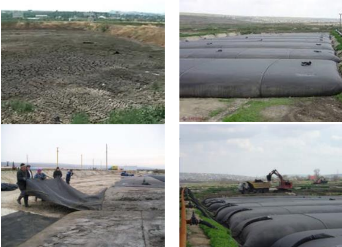
Figură 4-4 : Depozitarea si deshidratarea nămolului pe platformele de la SEAU Chisinau
