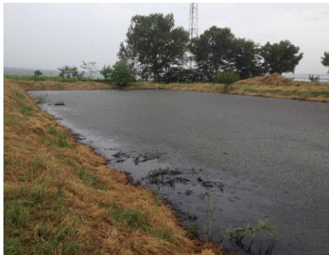
Figură 4-1 : Platforma de nămol încărcată de curind
